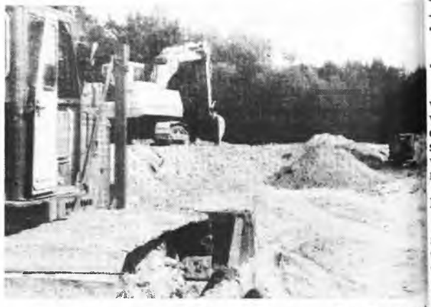
Prace przy wałe przeciwpowodziowym za Lgowem
