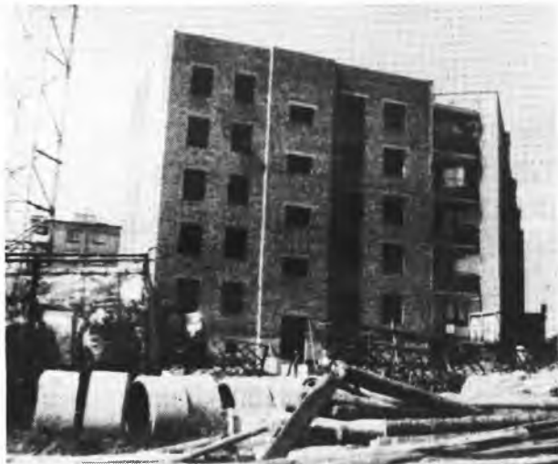
Jedyny aktualnie budowany blok mieszkalny w Jarocinie. Osiedle Konstytucji 3 Maja Fot. J.Stachowiak
