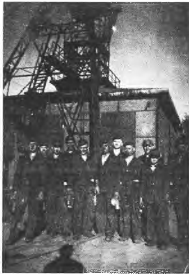
Po wyjeździe na powierzchnię - przed szybem
