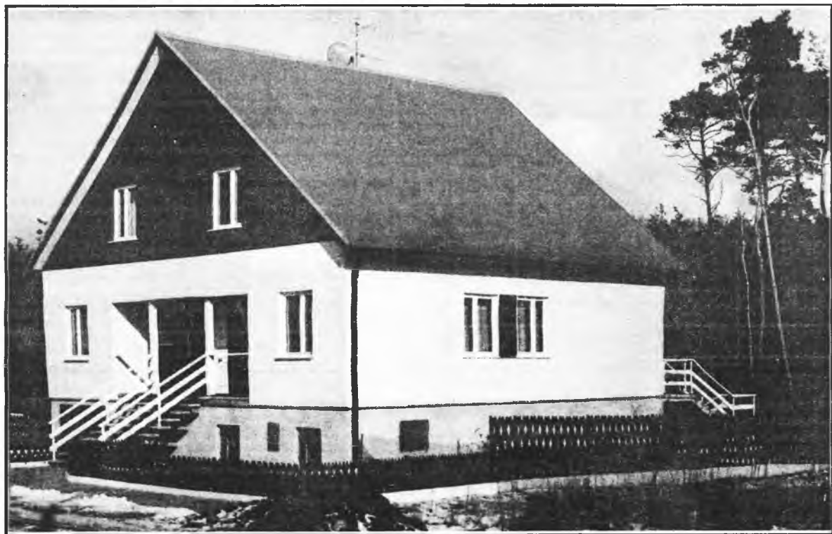
Dom J. i M. Sipurzyńskich. Niekonwencjonalna konstrukcja drewniana z elewacją z tworzywa sztucznego. Bardzo dobre własności termoizolacyjne. Krótki czas budowy (fot. J. Zwierzycki)
