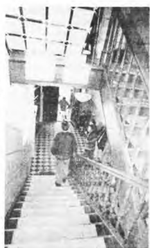
Po remoncie (zasługa głównie rodziców) w SzP w Magnuszewicach
