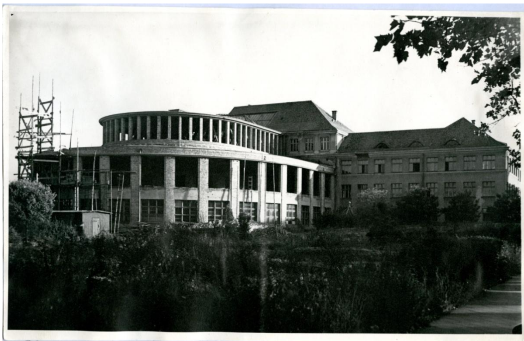
Ryc.93. Collegium Anatomicum w odbudowie po zniszczeniach wojennych
