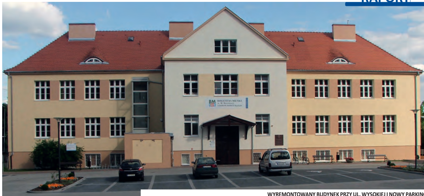
WYREMONTOWANY BUDYNEK PRZY UL. WYSOKIEJ I NOWY PARKING
