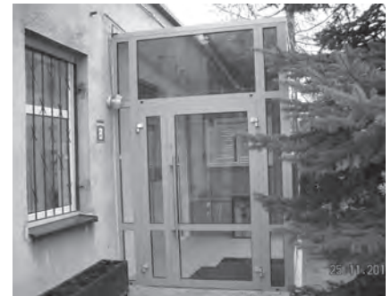
Nowe wejście do budynku urzędu
