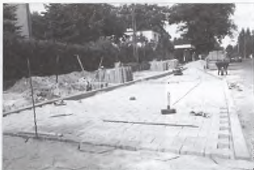
Prace przy ul. Poznańskiej (nowe chodniki i podjazdy)...
