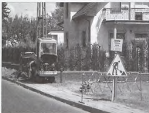
...i przy ul. Piaskowej (kanalizacja)
