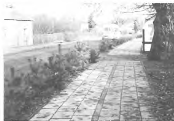
Przykład samowolnego zazieleniania – strach pomyśleć, jakie konsekwencje miałyby pozostawienie w tym miejscu sosen: te sosny z czasem ograniczą widoczność na łuku drogi, a swoimi korzeniami mogą uszkodzić istniejącą infrastrukturę.
