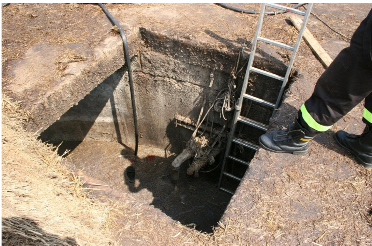
Rysunek 39 Dokumentacja dotycząca zbiornika gnojowicy o głębokości ok. 3m.
