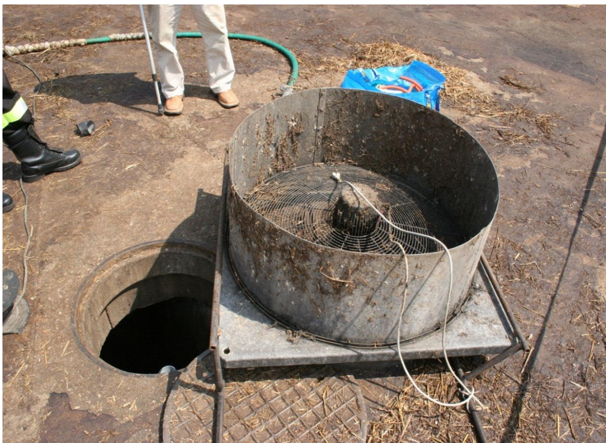
Rysunek 40 Dokumentacja – pracy wentylatora napowietrzającego zbiornik gnojowicy.
