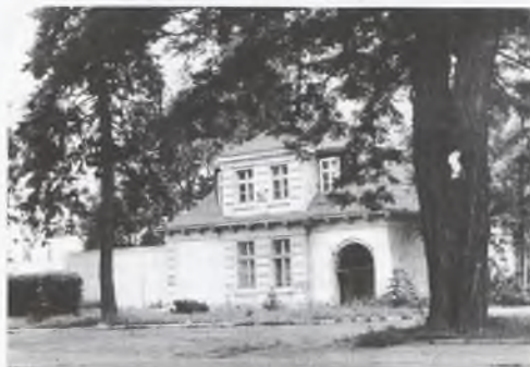
Remontowany budynek byłej poczty
