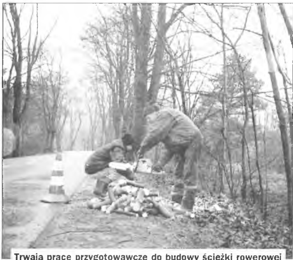
Trwają prace przygotowawcze do budowy ścieżki rowerowej
