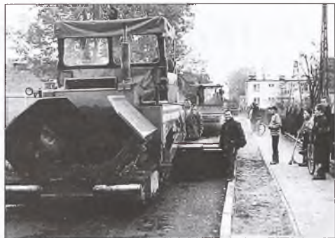
Budowa ulicy Ogrodowej w Chociczy
