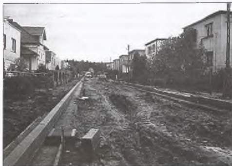
Prace na ul. Sosnowej w Nowym Mieście
