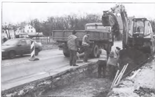
Modernizacja drogi w Kłęce
