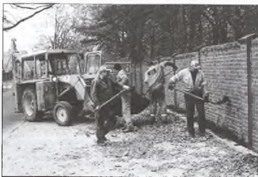
Remont drogi powiatowej w Klęce
