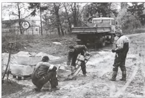
Utwardzanie drogi do szkoły w Klęce
