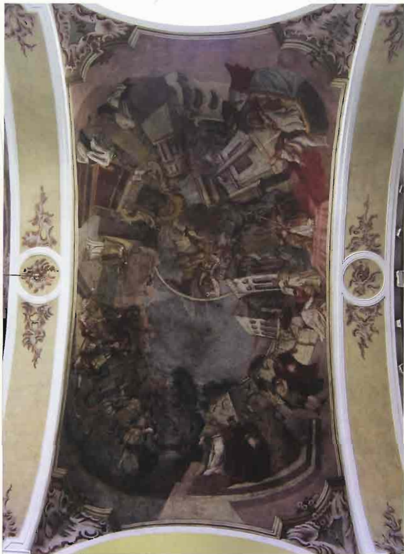
Fragmenty polichromii sklepienia kościoła
