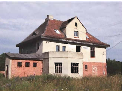
Anastazewo, budynek stacji kolejki wąskotorowej
