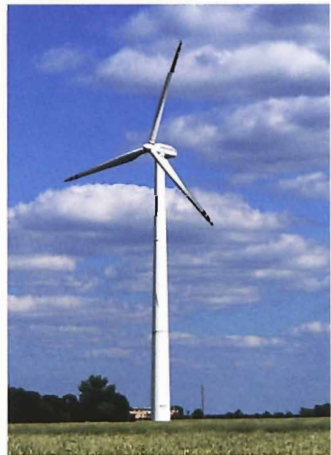
Kołaczkowo, wiatrak elektrowni wiatrowej
