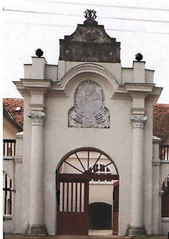
Trzemeszno, ozdobny łuk bramny przed budynkiem gimnazjum
