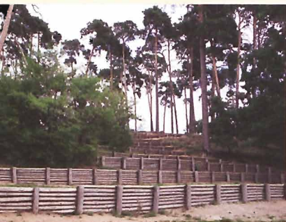
Rezerwat „Jeziro Dębiniec”, wzmocnienia skarp
