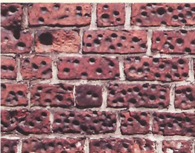
Dolki w ceglach kościoła pw. św. Michała Archanioła
