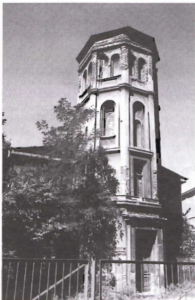
18. Wieża kantoru fabryki Cegielskiego przy ul. Strzeleckiej
