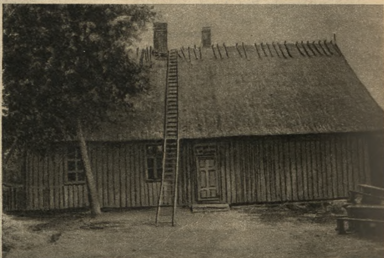
Dwuklasowa Publiczna Szkoła Powszechna w Raduni, pow. Kościerzyna, woj. pomorskie, zbudowana z drewna i kryta słomą, musi pomieścić 90 dzieci. Cała boczna ściana wysuwa się z nad fundamentu. Próchno sypie się z powały. Towarzystwo musi również przyjść z pomocą.
