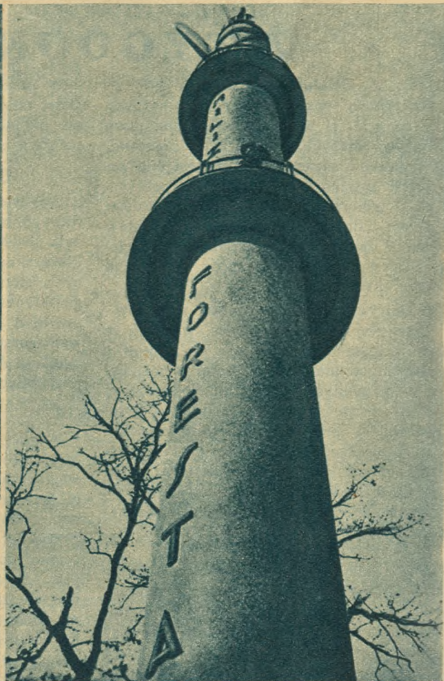
Na wzgórzach włoskich buduje się z rozkazu Mussoliniego olbrzymie 37-metrowe wieże obserwacyjne, wyposażone w radio, telefony i szkła powiększające. Specjalni strażnicy, zamieszkujący te wieże, pilnie patrolują okolice, aby wczas zapobiec szeregom się ostatnio we Włoszech pożarom lasów. Z. G.
