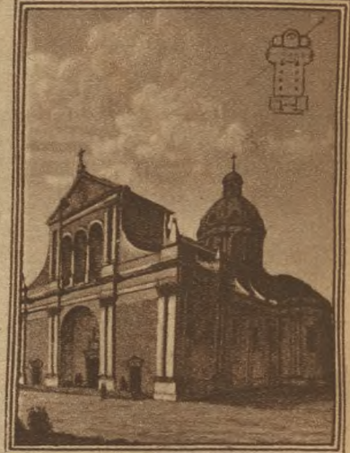
Projekt kościoła św. Stanisława (w budowie).
