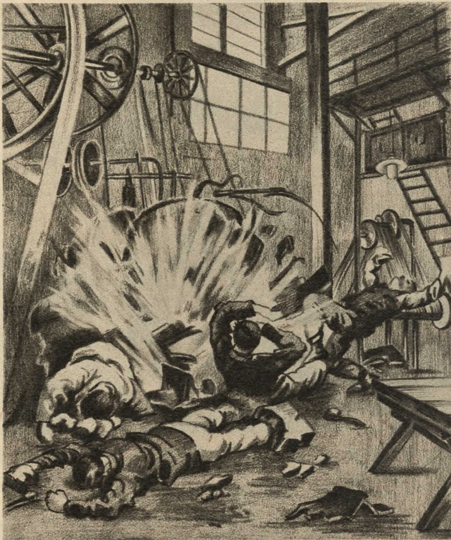
W godzinach porannych pękł kocioł w fabryce przędzalnianej.
