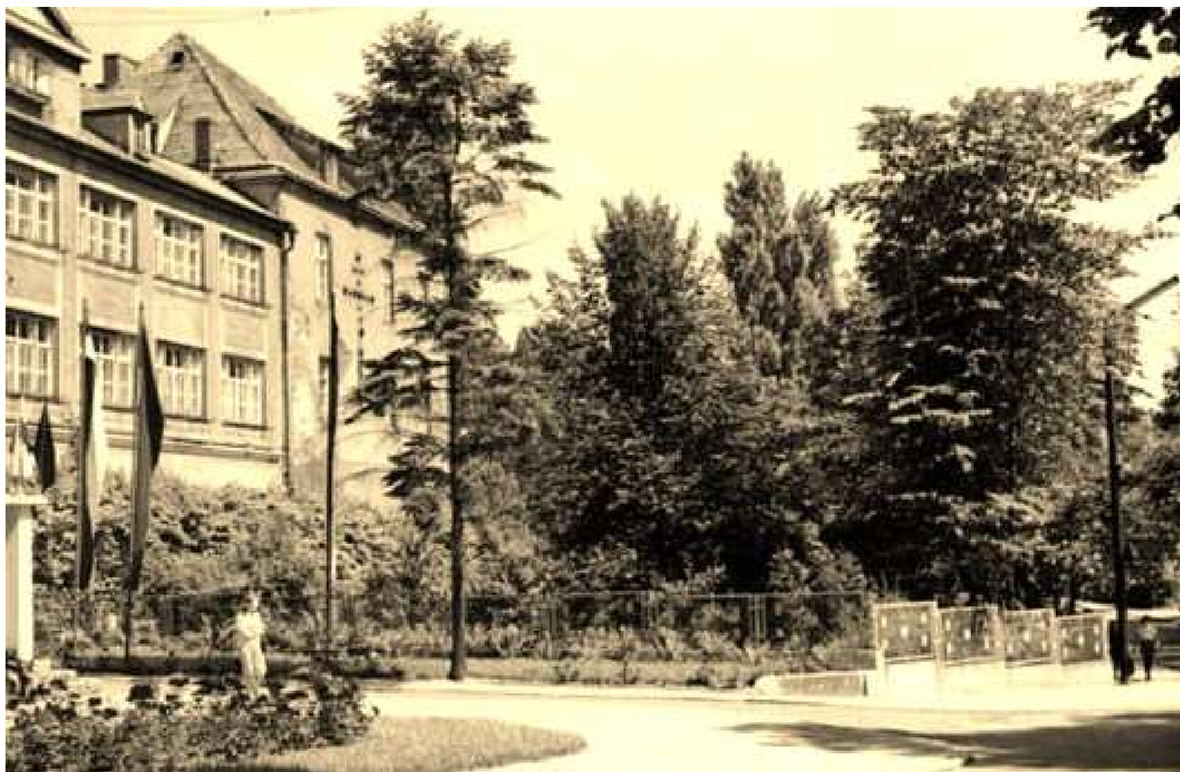
Frontowa część budynku WZR w Świebodzinie, rok 1974
