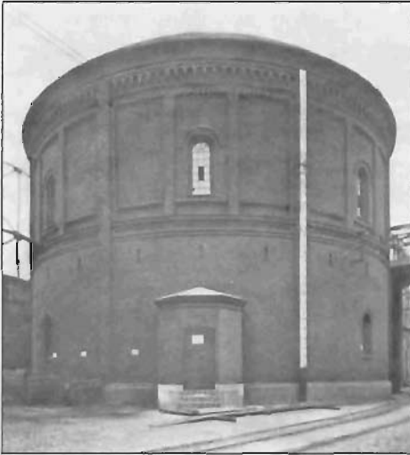
Zbiornik gazowy wybudowany przez fabrykę H. Cegielski dla Poznańskiej Gazowni w 1868 roku. Oddano ją do użytku dwa dni przed śmiercią Hipolita Cegielskiego
