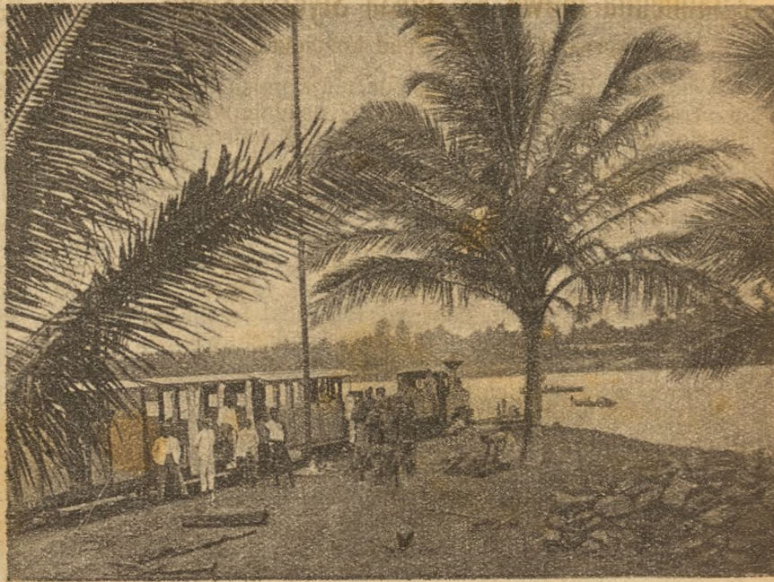
Kolej żelazna nad rzeką Zambezi.
