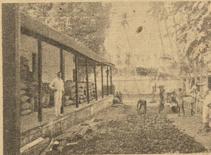
Podwórze domu kolonisty.
