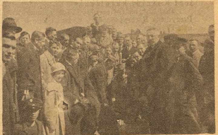
Zamurowanie aktu erekcyjnego w fundamentach.
