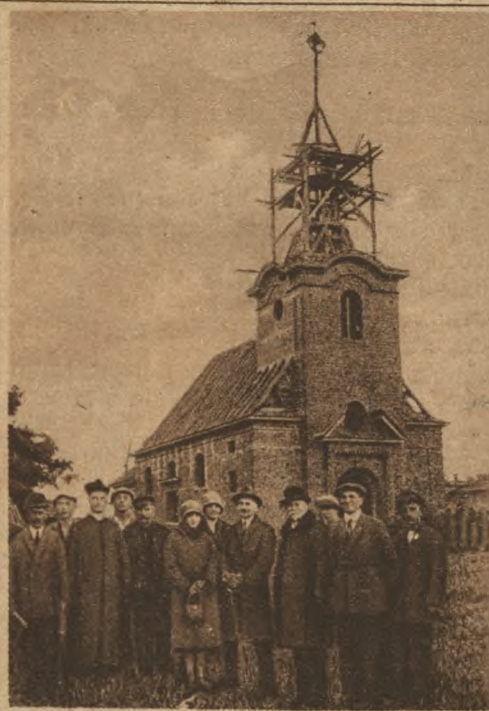
Budowa nowego kościoła w Koszutach. Po skończonej pracy starodawnym zwyczajem cieśle zawesili na szczycie wieży krzyż, uwieńczony zielenią i chorągiewkami.
