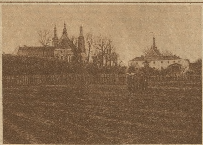
Kościół pobernardyński w Warcie p. Sieradzem (na lewo) i (na prawo) kościół po pp. bernardynkach oraz część gmachów klasztornych.
