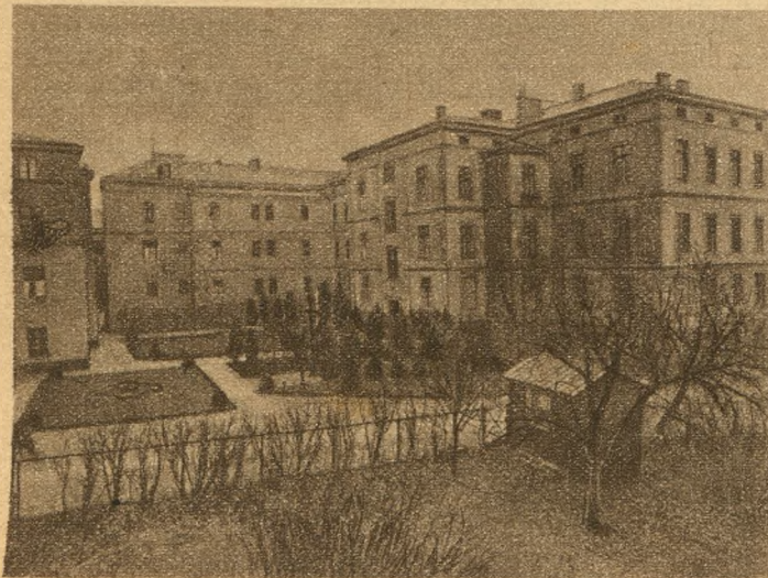
Szpital Przemienienia Pańskiego (widok od ogrodu).
