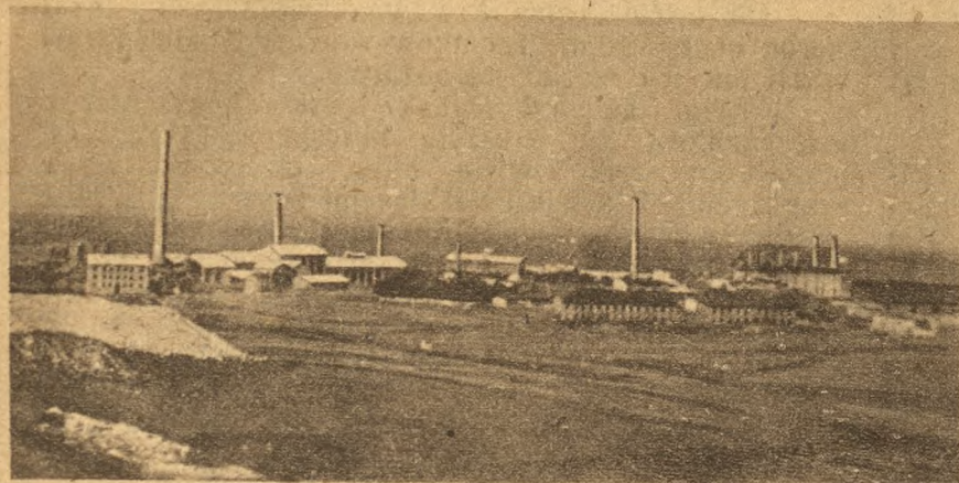
Ogólny widok trzech fabryk Tow. Wiek, Ogrodzieniec i Jan Jaks pod Zawierciem.
