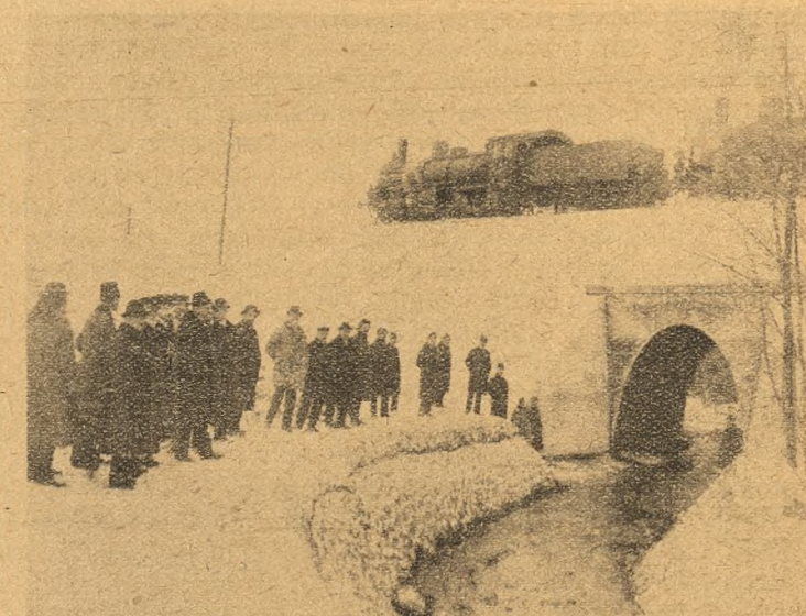
Przepust pod W. Kockiem.
