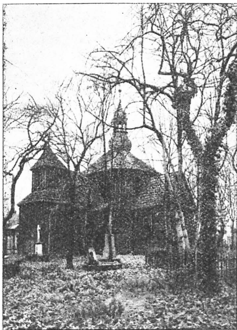
Krotoszyn. Kościółek drewniany, dziś kaplica na starym cmentarzu.
