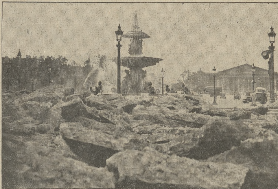
Plac de la Concorde w Paryżu w czasie przeprowadzanych tam obecnie robót ziemnych.
