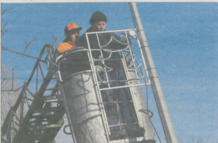
Świetlne elementy świąteczne mocowali pracownicy Usług Komunalnych.
