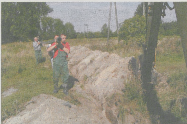
Pracownicy ZUK Dominowo podczas układania wodociągu.
