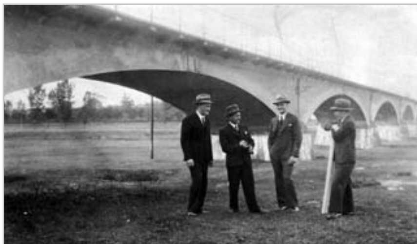
Konsultacje związane z remontem i modernizacją mostu. Pierwszy od prawej (z rulonem rysunków) Bogdan Dąbrowski, drugi od lewej – jego brat Bronisław.
